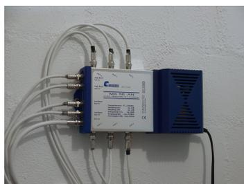
Abbildung 5 - Einspeisung am Multiswitch
